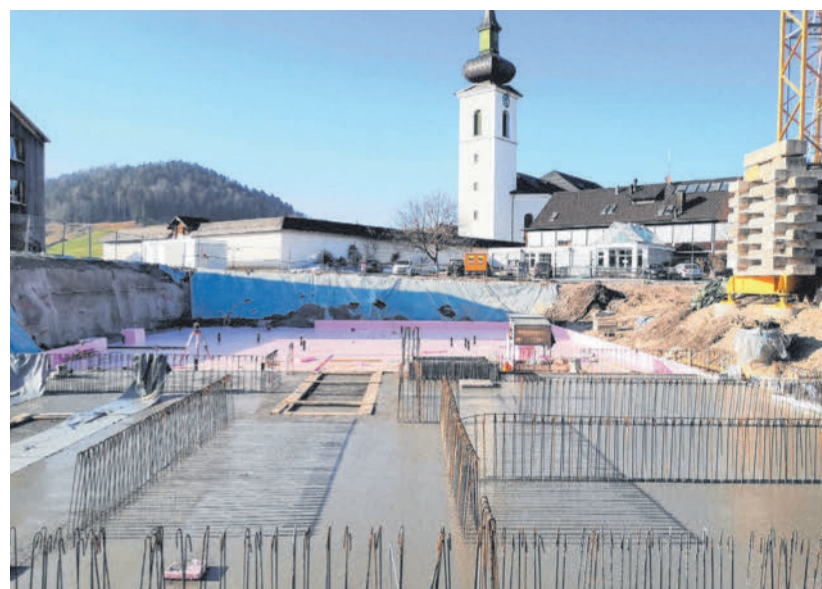
Fundamentierungsarbeiten für das neue Schulhaus für Mittelschule und Polytechnische Schule in Hittisau.
